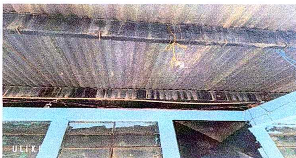
Foto 3: en la fotografía se observa las estructura de soporte de techo de metal ya muy deteriorada, por lo cual se pretende darle mantenimiento a cada uno.
