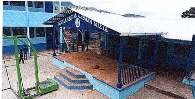
Foto 8: mejoramiento en repello y pintura
