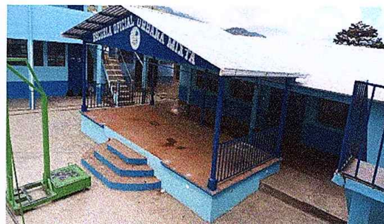
Foto 2: mejoramiento de estructura de techo escenario
