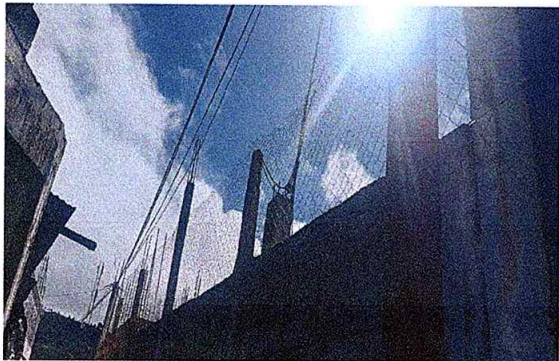
Foto 7: sustitución de malla galvanizada
