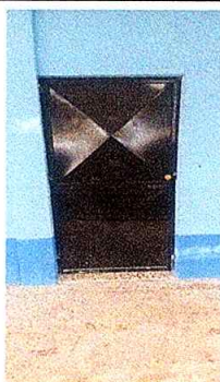
Foto 3: Sustitución de puerta de madera por metal
