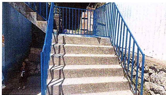
Foto 10: mejoramiento de barandas de metal
