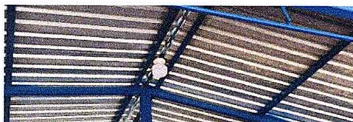
Foto 9: Reparación de sistema eléctrico
