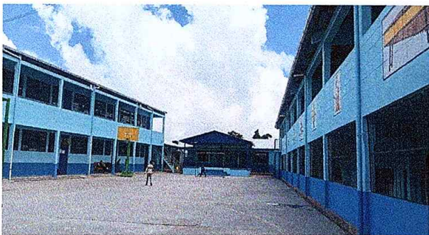
Foto 11: Mejoramiento de pintura exterior
