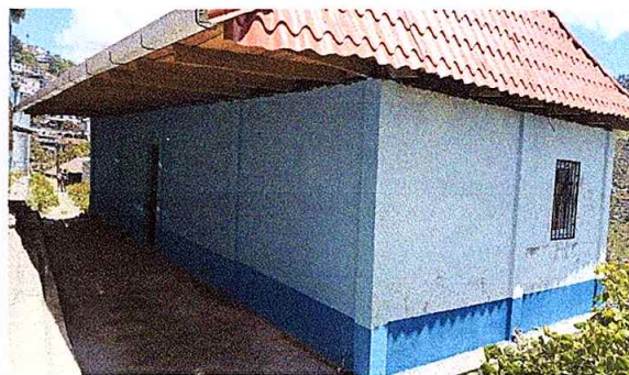
Foto 6: Plancha de concreto reparado
