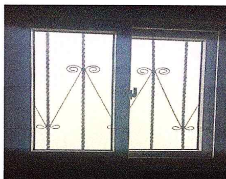
Foto 4: Cambio de ventanas de madera
