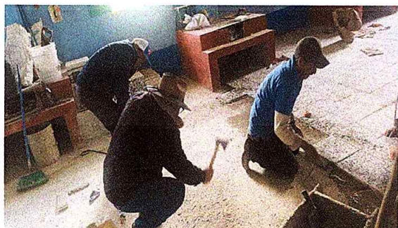
Foto 5: mejoramiento de piso de cocina con piso de granito y pintura de interior de concina
