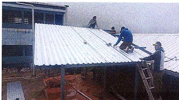
Foto1: sustitución de cubierta de lámina de escenario
