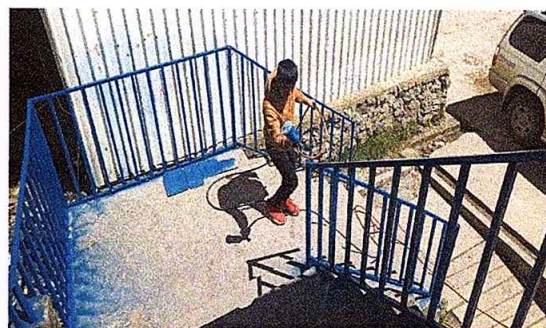
Foto 10: mejoramiento de barandas de metal
