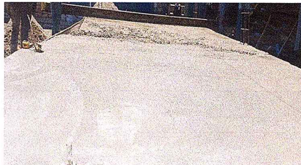
Foto 6: Reparación de planchas de concreto de patio
