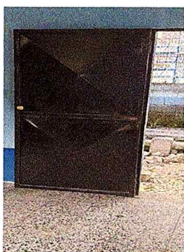
Foto 3: Sustitución de puerta de madera por metal
