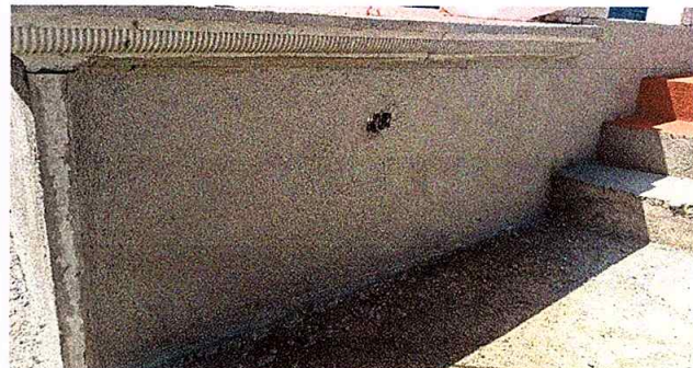
Foto 8: mejoramiento en repello y pintura
