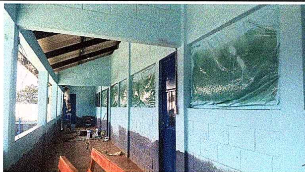
Foto 11: mejoramiento de pintura exterior
