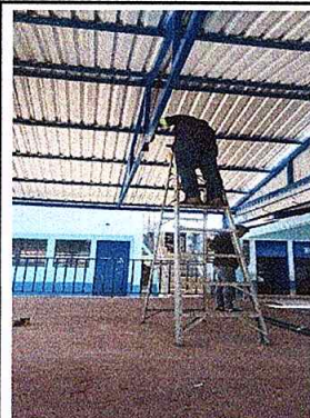
Foto 9: Reparación de sistema eléctrico
