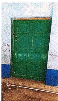
Foto 3: Sustitución de puerta de madera por metal
