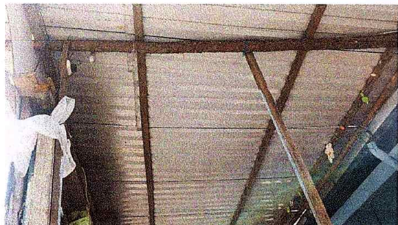
Foto1: sustitución de cubierta de lámina de escenario
