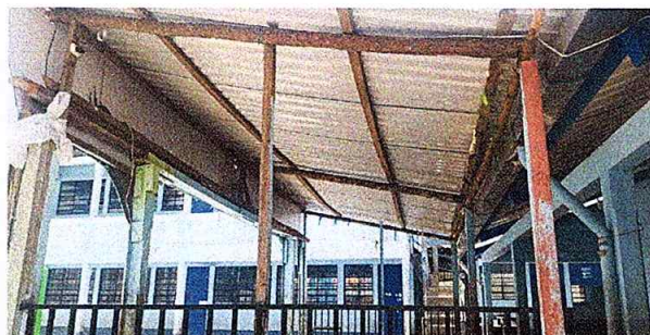
Foto 2: mejoramiento de estructura de techo escenario
