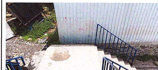
Foto 10: mejoramiento de barandas de metal
