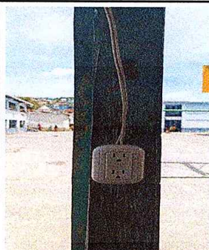
Foto 9: Reparación de sistema eléctrico
