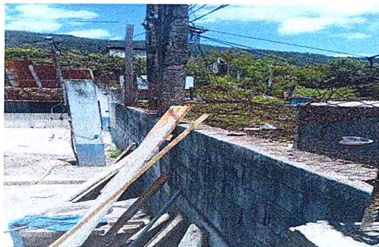
Foto 7: sustitución de malla galvanizada
