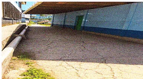
Foto 6: Reparación de planchas de concreto de patio
