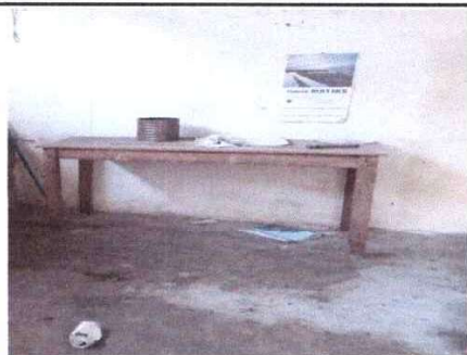
Foto 7: En la imagen se observa que el piso del aula se encuentra en mal estado a la cual se cambiara por piso de cemento líquido
