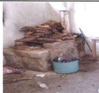
Foto 6: En la imagen se observa que el piso de la cocina se encuentra en mal estado, a la cual se cambiara por piso de cemento liquido.
