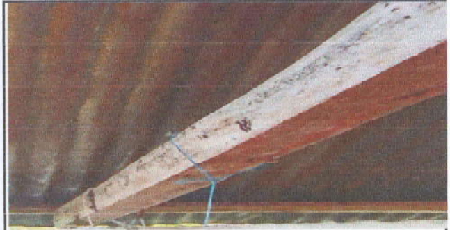
Foto 2: sustitucion de estructura portante en cocina
