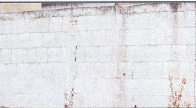
Foto 5: Repello en muro de cocina
