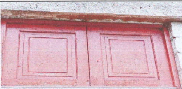
Foto 3: Sustitucion de ventanas de maderas a metal, más vidrios 3.35*1.20
