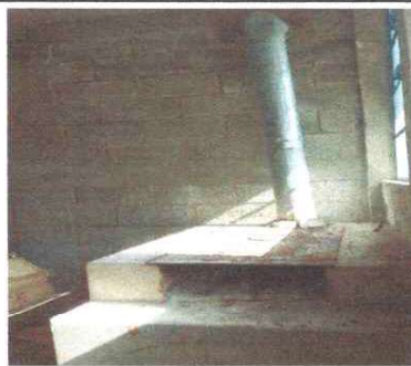
Foto 4: Sustitución de la plancha de tres ornillas en la cocina
