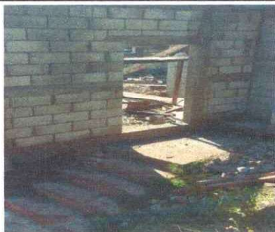
Foto 1: Sustitución de puerta por metal en la cocina
