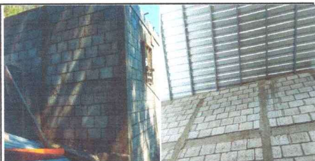
Foto 5: Repello interior y exterior de la cocina
