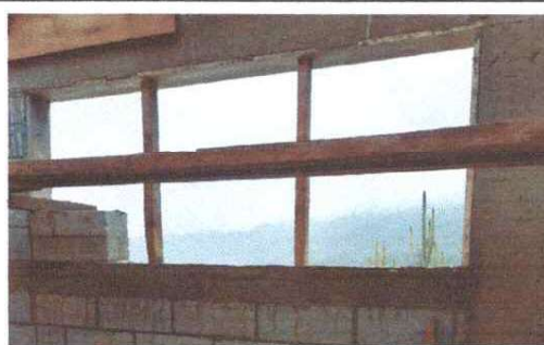
Foto 2: Sustitución de ventana de madera por metal y vidrio en la cocina
