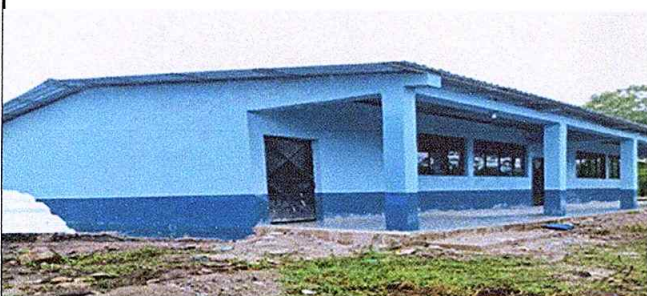
Foto 3: repello exterior finalizado
