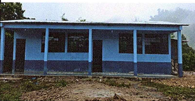
Foto 5: pintura exterior finalizado
