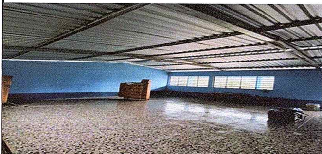
Foto 1: pintura finalizado interior
