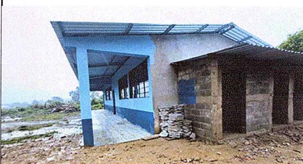
Foto 4: piso exterior finalizado
