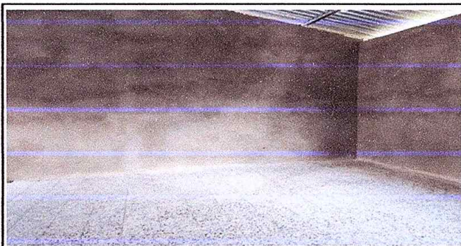
Foto 3: Sustitución de piso de granito
