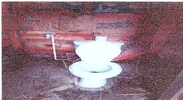
Foto 3: Sustitucion de inodoro
