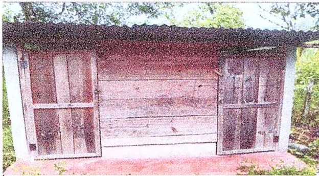
Foto 1: Cubierta de laminas
