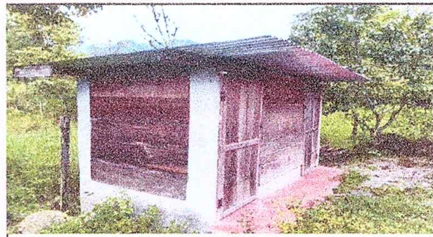
Foto 2: Estructura de techo
