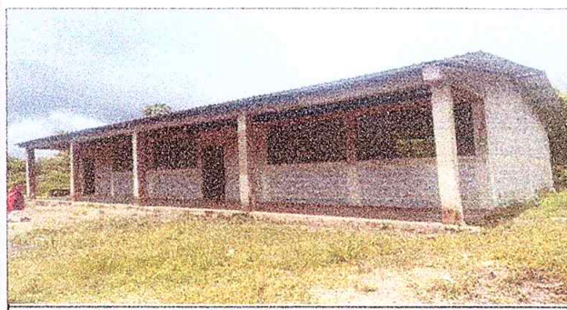
Foto 5: Sustitucion de repello y cernidos
