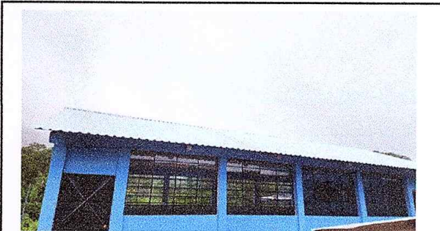
Foto 6: Mejoramiento de lamina y estructura.
