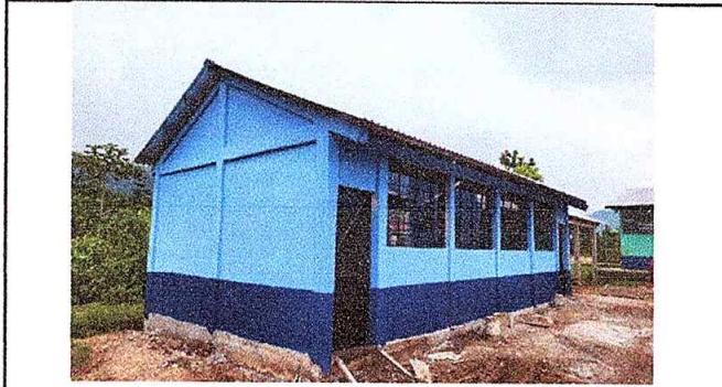
Foto1: Vista panoramica del mejormiento de techo, estructura, puertas, ventanas, y pinturas
