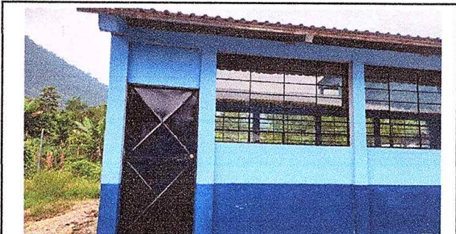
Foto 3: Mejoramiento de puertas de metal
