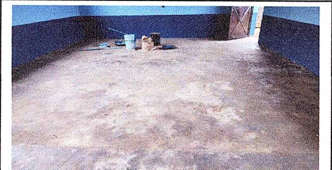
Foto 5: Mejoramiento con piso de torta de cemento
