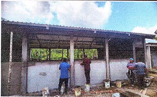
Foto 3: Colocación de repello en muros.
