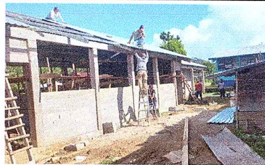
Foto 6: Vista panoramica de colocación de lamina aluzinc.
