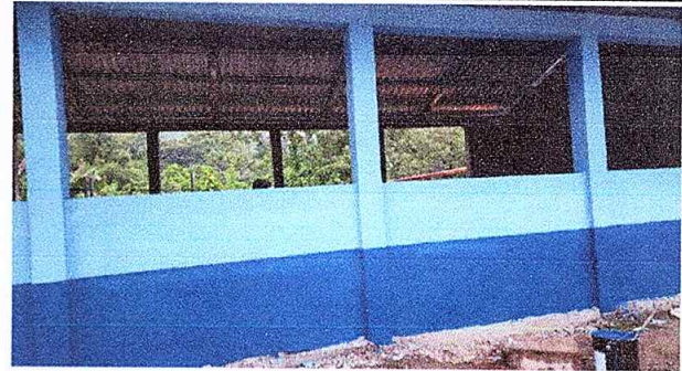
Foto 4: Pintura en muros interiores y exteriores.
