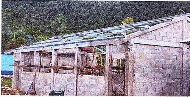
Foto1: Colocación de la estructura de soporte.
