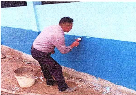
Foto 5: Pintura en muro exterior.
