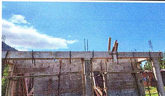
Foto 1: Mejoramiento con lámina, capote y estructura en cocina.
