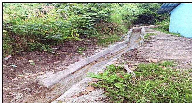
Foto 5: Finalización de cuneta mejorado
