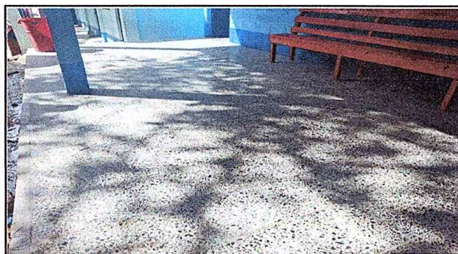
Foto 3: Finalización de colocación piso de granito
