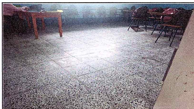
Foto 3: Finalización de colocación piso de granito
