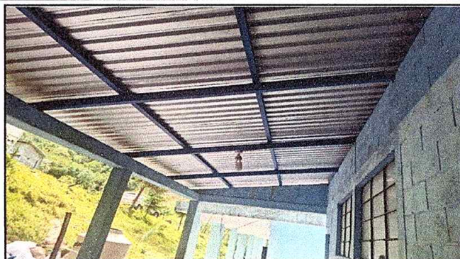
Foto 2: Finalización de colocación de estructura de techo de metal
