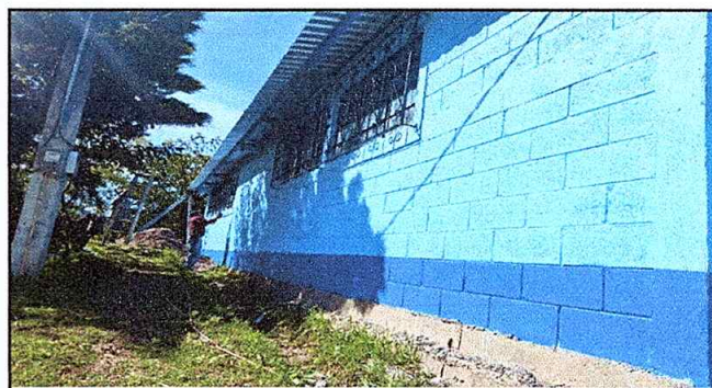
Foto 6: Finalización de aplicación de pintura en muros exteriores e interiores
