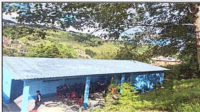
Foto 3: Finalización de colocación de laminas en el techo de las aulas
