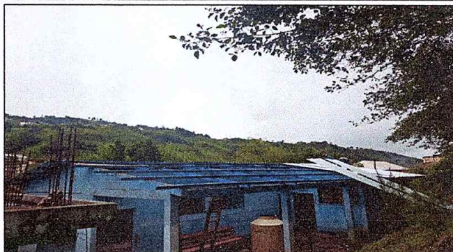
Foto 2: Colocación de estructura de techo de metal
