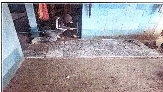
Foto 3: Colocación piso de granito
