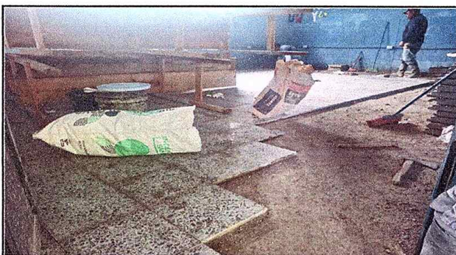
Foto 3: Colocación piso de granito
