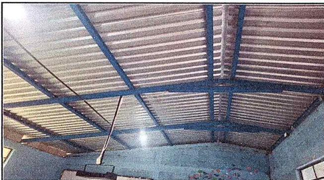
Foto 3: Colocacion de laminas en el techo de las aulas
