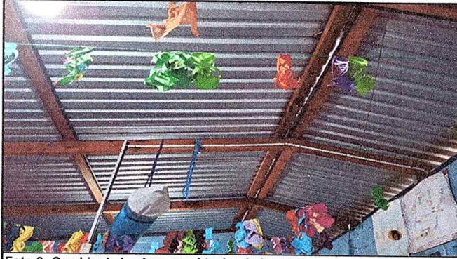
Foto 3: Cambio de laminas en el techo de las aulas
