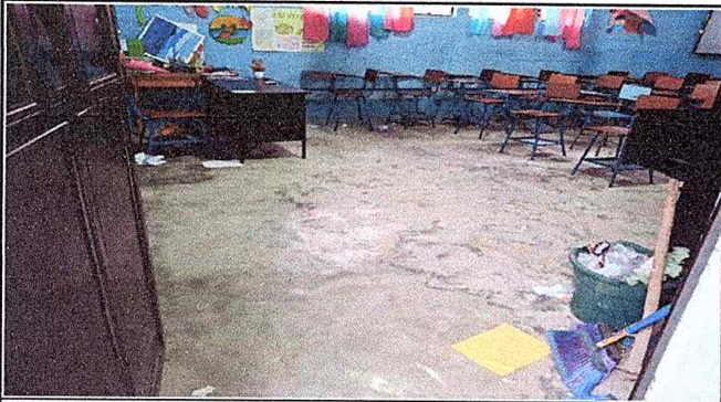
Foto 3: Sustitución de piso cemento por piso de granito
