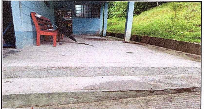
Foto 4: Sustitución de piso de cemento por piso de granito
