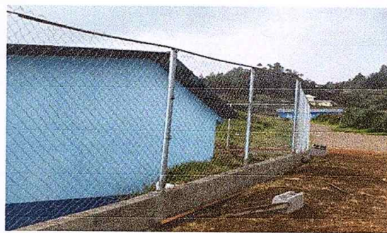
Foto 6: Trabajo terminado de instalación de malla galvanizado.
