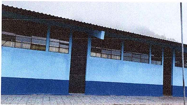
Foto1: Trabajo terminado de colocación de piso de granito, en el corredor del centro educativo
