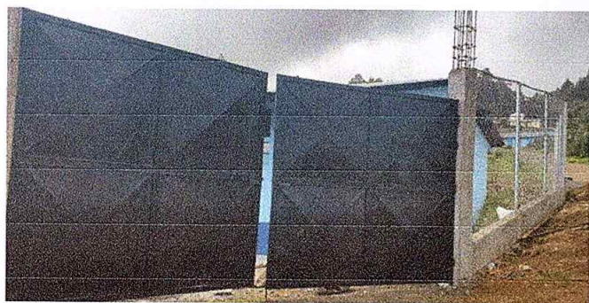
Trabajo terminado de instalación de porton.
