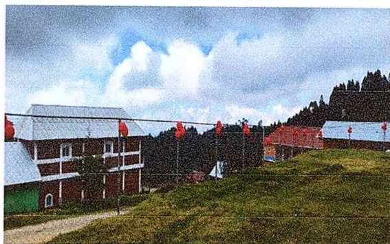
Foto 4: Trabajo terminado de tubos galvanizados
