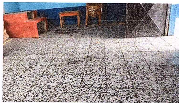
Foto 2: Trabajo terminado de colocación de piso de granito en cocina
