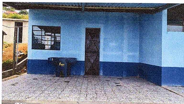
Foto 3: Trabajo terminado de colocación de piso de granito, en el corredor de la cocina.
