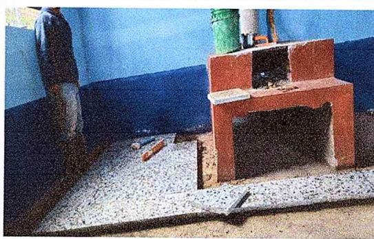
Foto 2: Colocación de piso de granito en la cocina.
