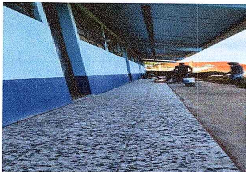
Foto 1: Colocación de piso de granito, en el corredor del centro educativo.
