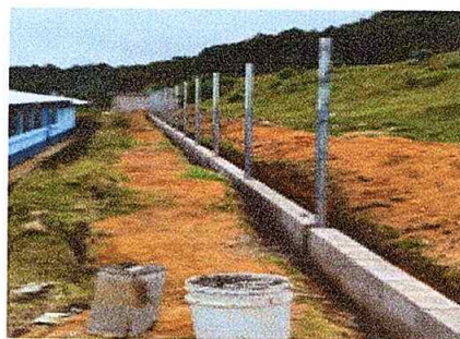
Foto 6: sustitución de circulación de madera por tubo galvanizado.
