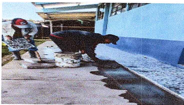
Foto 3: Colocación de piso de granito, en el corredor de la cocina.
