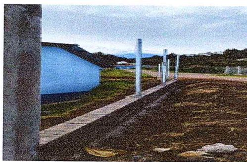
Foto 4: Instalación de tubos galvanizados de cerco para la circulación del centro educativo.
