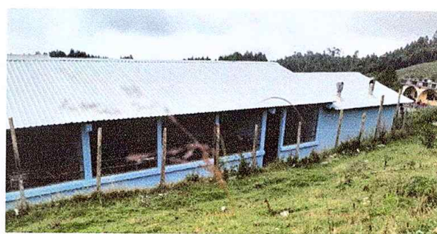
Foto 6: mejoramiento de circulación
