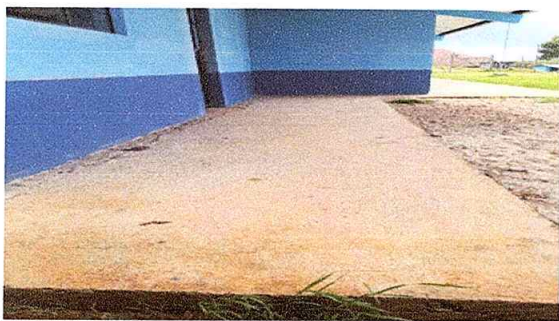
Foto 3: Sustitución de piso de granito, corredor cocina
