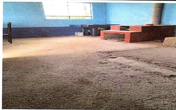
Foto 2: Sustitución de piso de granito en cocina
