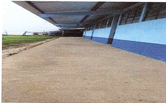
Foto 1: Sustitución de piso de granito, corredor del centro educativo
