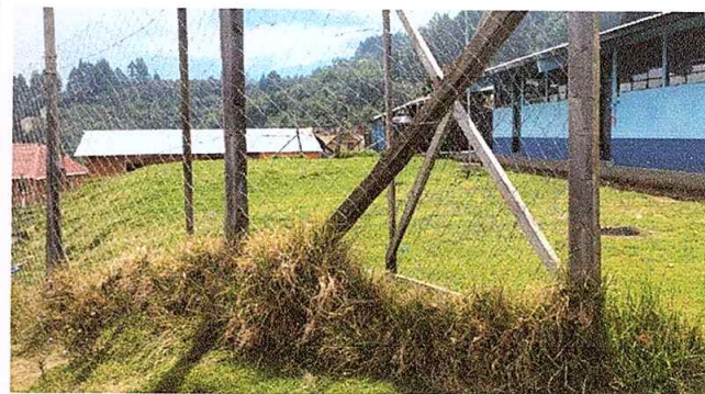
Foto 4: Sustitución de tubos galvanizados
