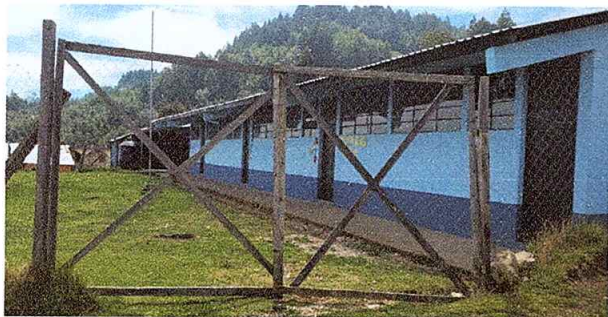
Foto 5: Sustitución de portón
