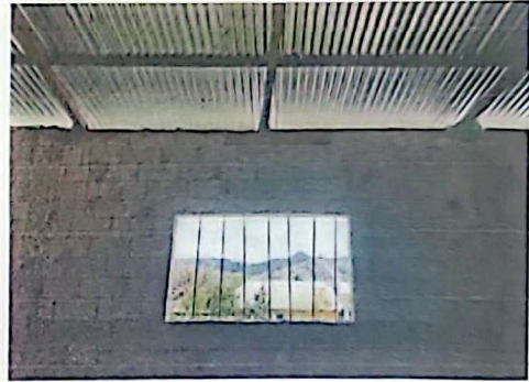
Foto 2: Sustitución de venanas de madera por metal mas vidrio
