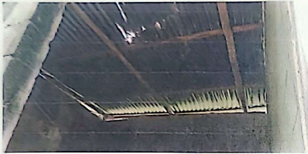
Foto1: Sustitución de lamina troquelada aluzinc calibre 26
