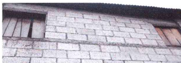
Foto 5: Sustrucción de ventanas de madera a metal en la cocina
