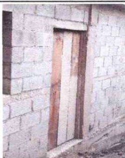
Foto 3: Sustrucción de puertas de madera a metal
