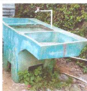
Foto 12: Sustitucion de pila en mal estado
