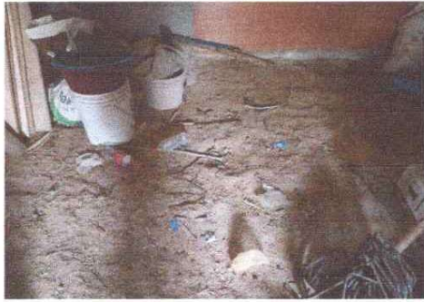
Foto 7: Mejoramiento de piso de tierra a torta de concreto y piso de cemento liquido en la cocina
