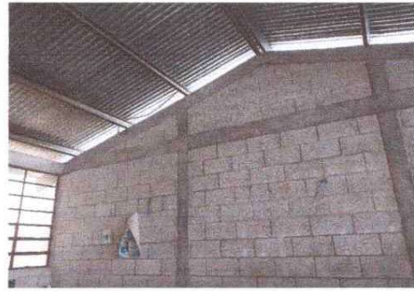
Foto 8: Pintura en muros exteriores e interiores de las aulas
