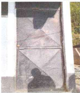
Foto 11: Mantenimiento a estructura de puertas de mal estado y oxidado (lijado, cambio de tubo, cepillado, sujeciones, aplicación de pintura)
