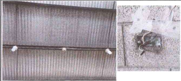
Foto 10: Sustitución del sistema electrico, focos, plafoneras, interruptores y tomacorrientes
