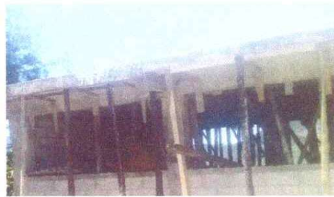
Foto 2: Mejormiento de ventanas de madera a ventanas con vidrios
