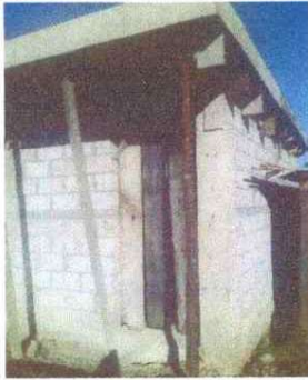
Foto1: Sustrución de puerta de madera en metal para aula
