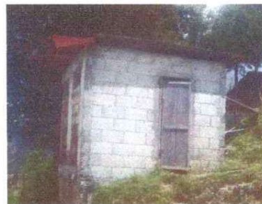
Foto 10: Repello y pintura en los baños
