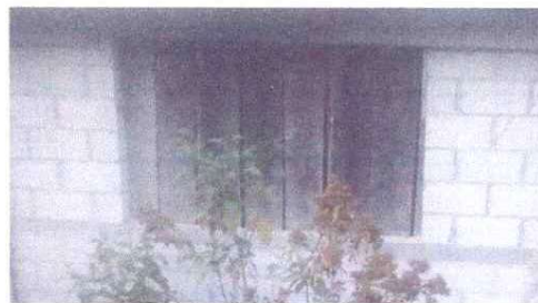
Foto 18: Ventanas traseras del aula
