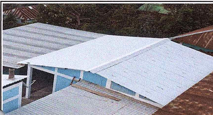
Foto1: Culminación del remozamiento del establecimiento.
