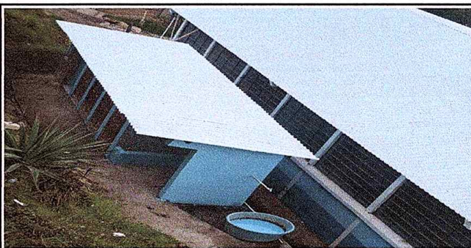
Foto 6: Culminación de instalacion de laminas y estructura de soporte.
