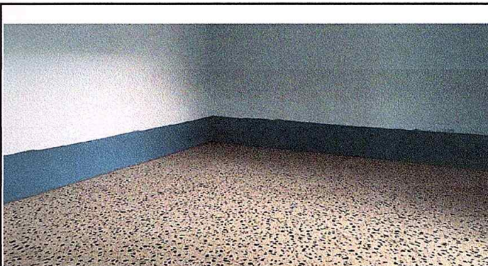
Foto 4: Culminación del remozamiento del establecimiento.
