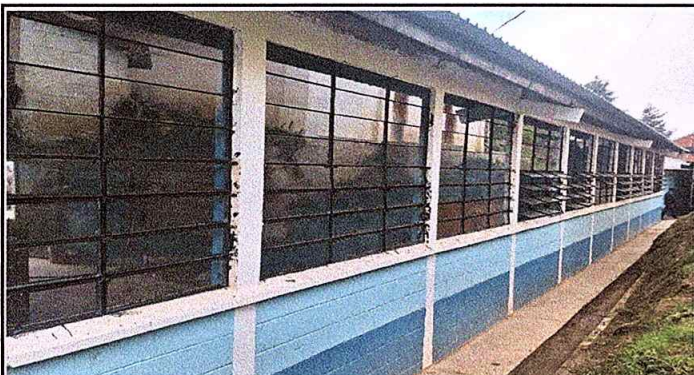
Foto 3: Culminación del remozamiento del establecimiento.
