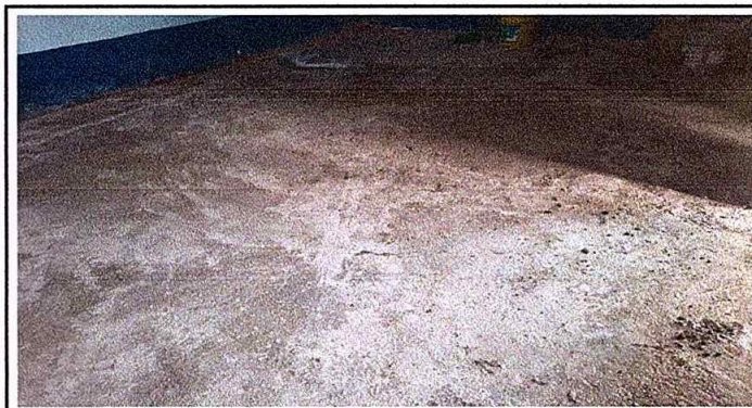
Foto 4: Sustitución de piso de granito
