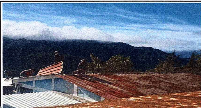
Foto1: Sustitución de lámina, por lámina troquelada aluzinc calibre 26 en edificio de aula
