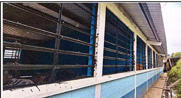
Foto 3: Sustitución de Vidrios
