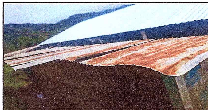
Foto 6: Sustitución de laminas y estructura de soporte
