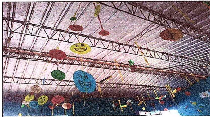
Foto2: Reparación de sistema Eléctrico, Foco, Plafonera; ducto
