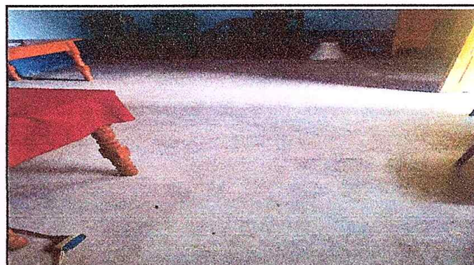
Foto 4: Sustitución de piso de granito
