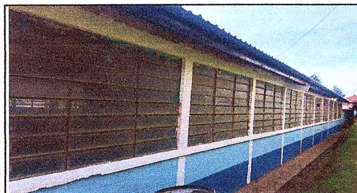
Foto 3: Sustitución de Vidrios
