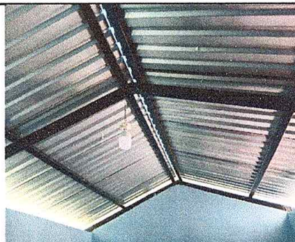
Foto 4: Finalización de la colocación de láminas troqueladas aluzinc calibre 26
