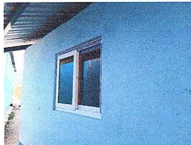
Foto 2: Colocación de ventana de metanal PVC en la cocina al cien por ciento entregado.
