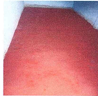
Foto 10: Terminado el piso de cemento
