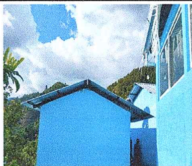
Foto 6: Finalización de repello en muro
