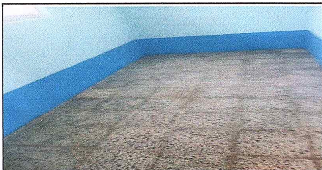
Foto 3: Finalizado el trabajo de colocación de piso de granito
