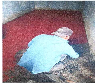
Foto 10: En proceso de sustitución de piso de grano por piso de cemento
