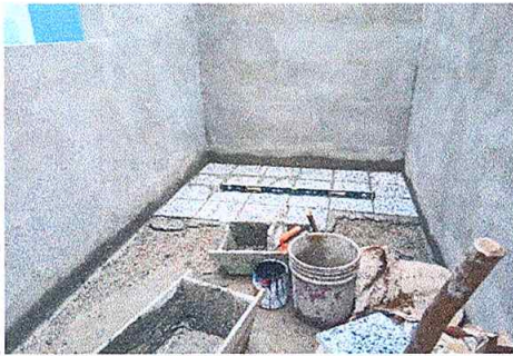
Foto 9: En proceso de sustitución de piso de concreto por piso de granito
