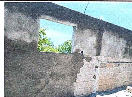
Foto 6: En proceso de repello en muro
