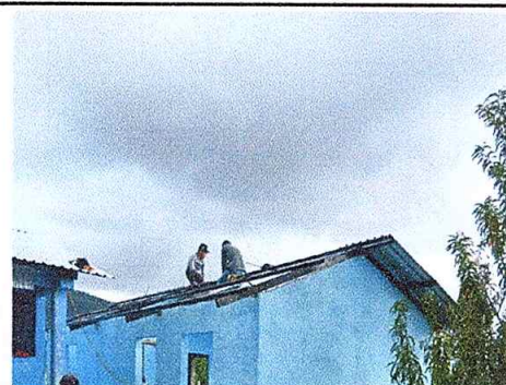
Foto 4: En proceso de sustitución de laminas por láminas troqueladas aluzinc calibre 26
