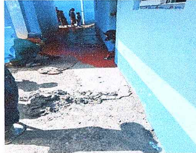
Foto 8: En proceso de sustitución de torta de concreto por cemento líquido
