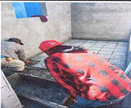
Foto 3: En proceso de sustitución de piso de torta de concreto por piso de granito
