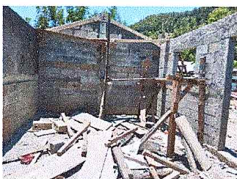
Foto 5: Durante el mejoramiento de pared
