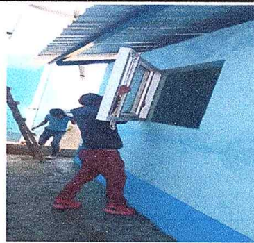
Foto 2: En proceso de sustitución de ventana de madera por metano de PVC en la cocina
