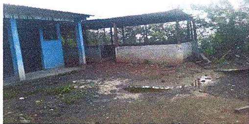
Foto 5: Mejoramiento de pared
