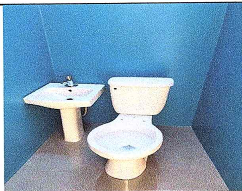
Foto 4: Inodoro y lava manos ya instalados, listo para usar.
