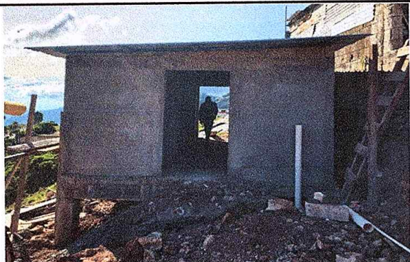
Foto1: Culminación del proyecto de baños, antes de otras instalaciones.
