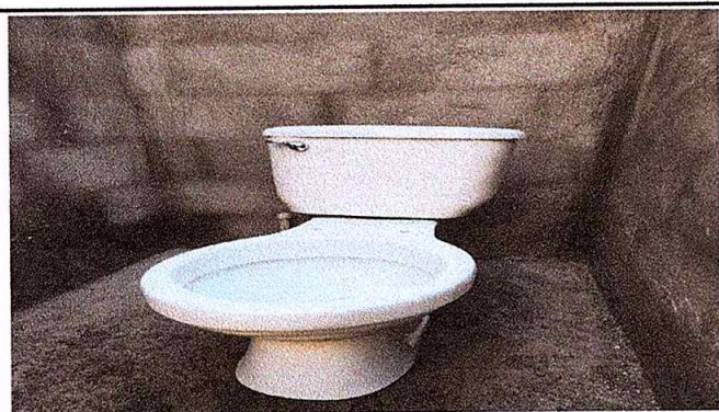
Foto 3: Proceso de instalación de inodoros y lava manos.
