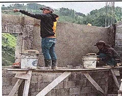
Foto 4: Avance en el proceso de mejoramiento de paredes para la pintura.
