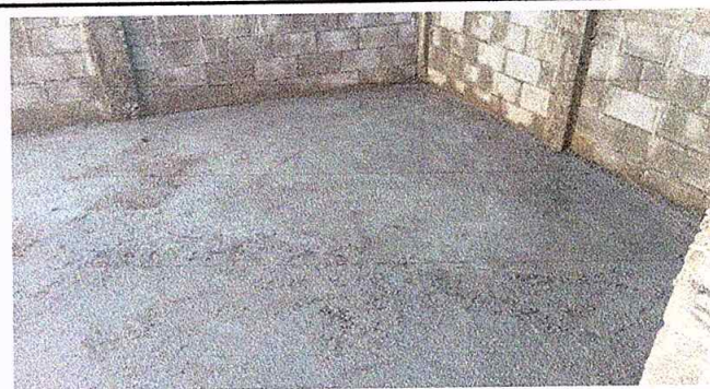
Foto 2: Proceso de sustitución de piso con torta de concreto.
