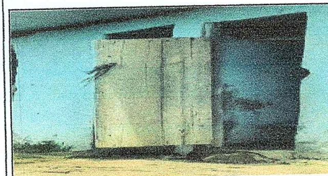
Foto 5: Sustrucción puertas para baños
