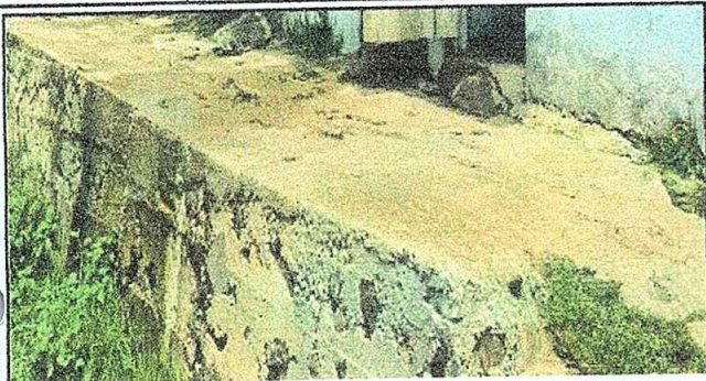
Foto1: Sustrucción torta de concreto para baños
