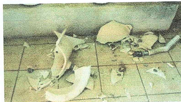
Foto 4: Sustrucción de lavamanos
