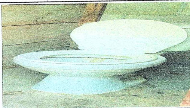
Foto2: Sustrucción de inodoros
