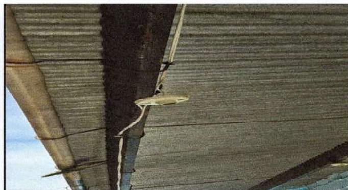
Foto 4: Sustrucción de plafoneras
