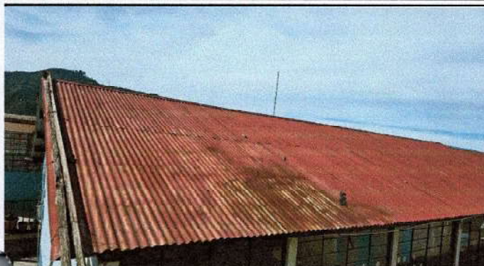
Foto1: Sustrucción de lámina, por lámina troquelada aluzinc calibre 26 en edificio 1 de aulas
