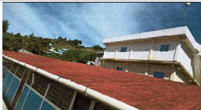
Foto2: Sustrucción de lámina, por lámina troquelada aluzinc calibre 26 edificio 2 de 3 aulas
