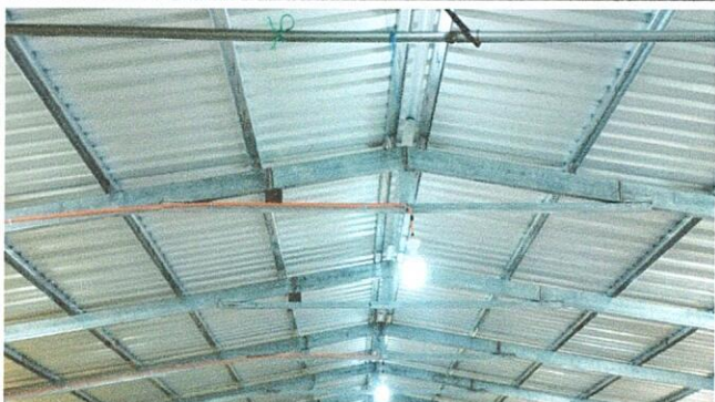
Foto 1.2: SUSTITUCIÓN DE CAPOTE DE LÁMINA, PARA LÁMINA TROQUELADA
