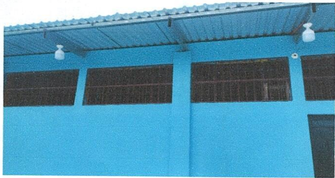
Foto 3.2: SUSTITUCIÓN DE PLAFONERAS
