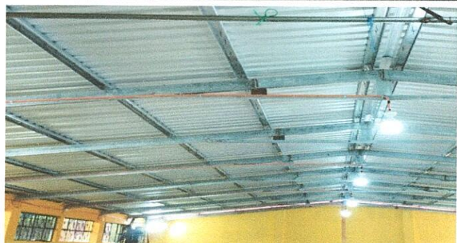
Foto 3.4: REPARACIÓN DEL CABLEADO ELECTRICO
