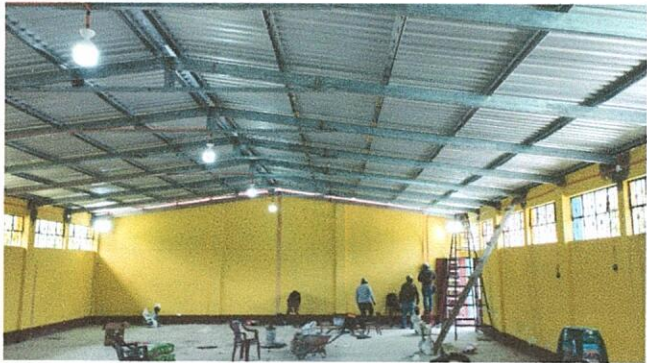
Foto 3.1: SUSTITUCIÓN DE FOCOS AHORRADORES
