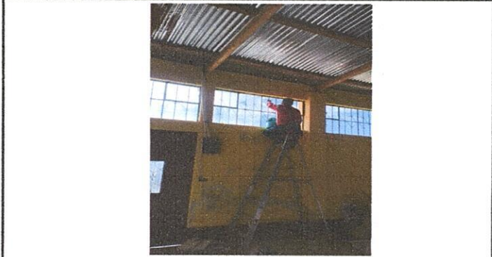
Foto 4: SUSTITUCIÓN DE VIDRIOS 40 CENTIMETROS POR 50 CENTIMETROS
