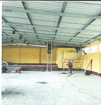
Foto 3.4: REPARACIÓN DEL CABLEADO ELECTRICO
