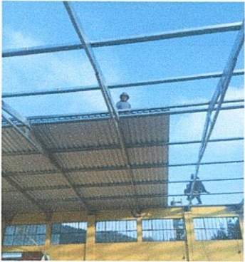
Foto 1.1: SUSTITUCIÓN DE LÁMINA, POR LÁMINA TROQUELADA TERNIUM CALIBRE 26
