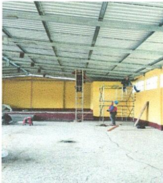
Foto 3.1: SUSTITUCIÓN DE FOCOS AHORRADORES
