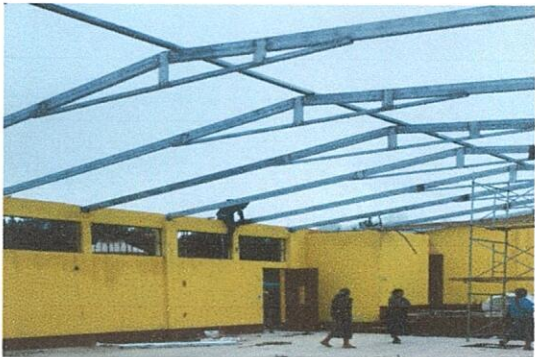
Foto 2.2: SUSTITUCIÓN DE ESTRUCTURA DE SOPORTE DE MADERA, POR METAL
