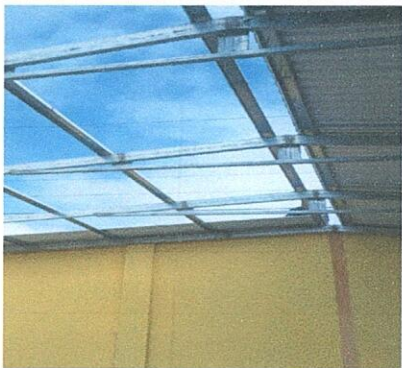
Foto 1.2: SUSTITUCIÓN DE CAPOTE DE LÁMINA, PARA LÁMINA TROQUELADA
