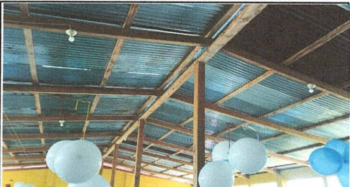
Foto 1.2: SUSTITUCIÓN DE CAPOTE DE LÁMINA, PARA LÁMINA TROQUELADA
