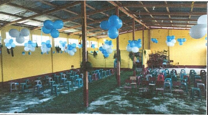
Foto 2.2: SUSTITUCIÓN DE ESTRUCTURA DE SOPORTE DE MADERA, POR METAL
