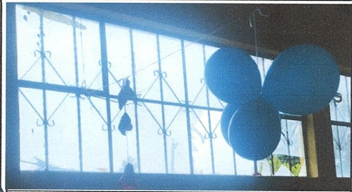
Foto 5: SUSTITUCIÓN DE VIDRIOS 40 CENTIMETROS POR 50 CENTIMETROS
