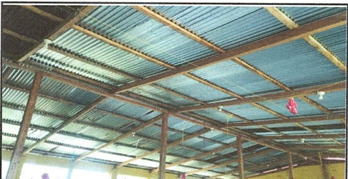
Foto 3.4: REPARACIÓN DEL CABLEADO ELECTRICO
