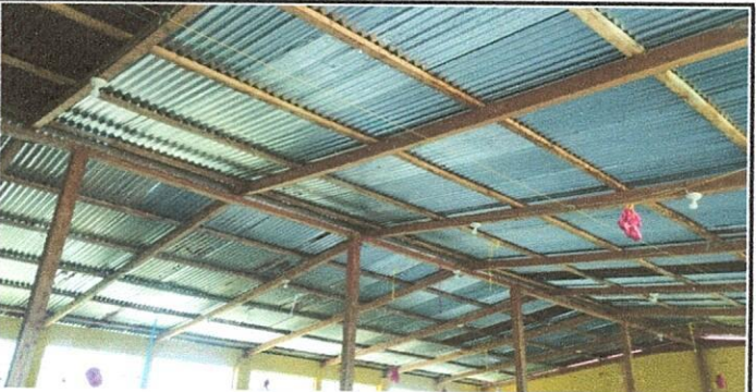
Foto 3.2: SUSTITUCIÓN DE PLAFONERAS
