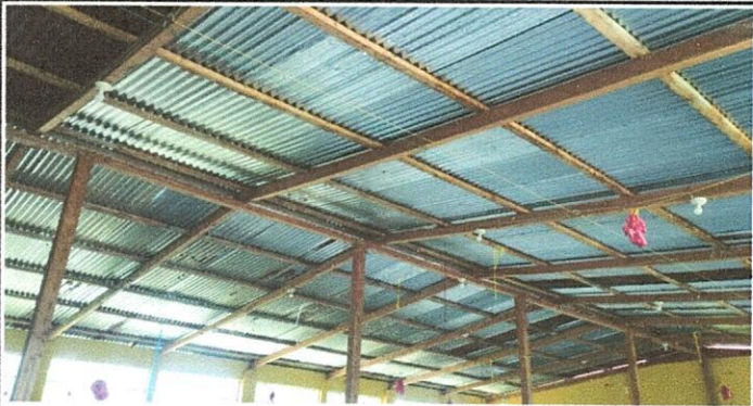
Foto 1.1: SUSTITUCIÓN DE LÁMINA, POR LÁMINA TROQUELADA TERNIUM CALIBRE 26
