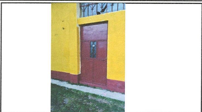
Foto 6.1: SUSTITUCIÓN DE UNA PUERTA DE METAL CON LAS MEDIDAS, DE ALTURA 2.25 METROS Y DE ANCHO 1 METRO.
