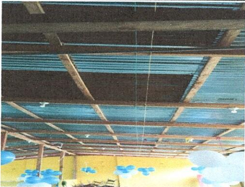
Foto 3.1: SUSTITUCIÓN DE FOCOS AHORRADORES
