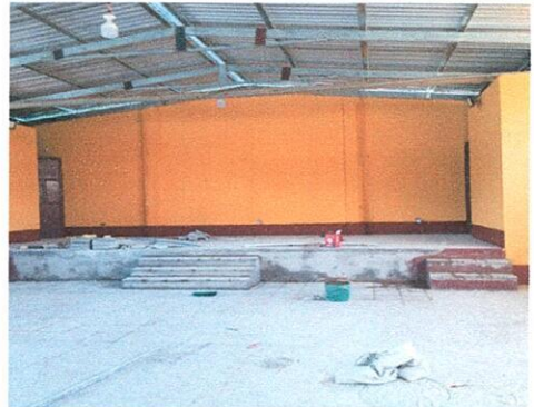
Foto 2.3: SUSTITUCIÓN DE PISO DE GRANITO.
