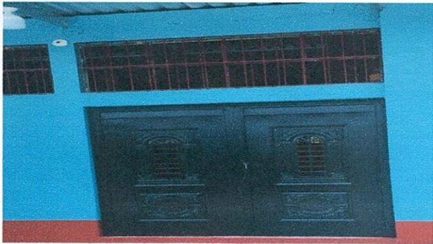
Foto1: SUSTITUCION DE PUERTA DE METAL (2.25 METROS x 2 METROS)
