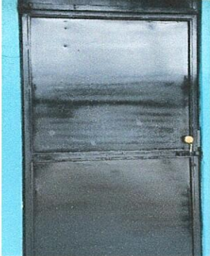
Foto : 6: SUSTITUCION DE CHAPAS MARCA YALE
