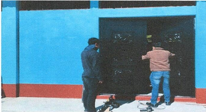
Foto1: SUSTITUCION DE PUERTA DE METAL (2.25 METROS x 2 METROS)
