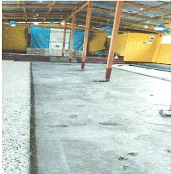
Foto 2.3: SUSTITUCIÓN DE PISO DE GRANITO.
