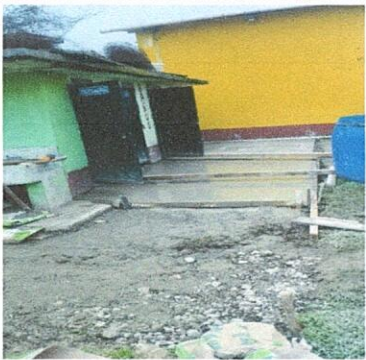
Foto 2.2: SUSTITUCION DE PISO DE TORTA DE CONCRETO, CORREDOR DE BAÑOS.
