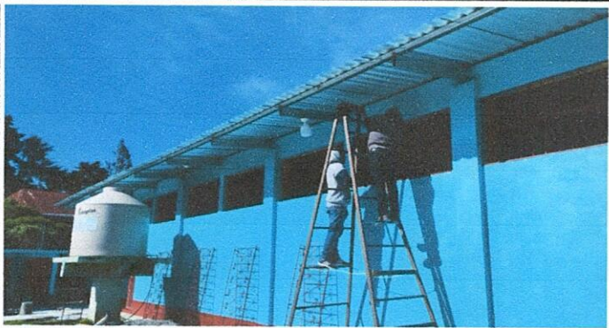
Foto 7: SUSTITUCIÓN BALCONES DE METAL
