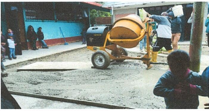
Foto 2.1 : SUSTITUCION O REPARACION DE PISO DE TORTA DE CONCRETO, CORREDOR DE COCINA
