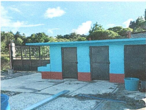
Foto 5: MANTENIMIENTO A ESTRUCTURA DE PUERTAS DE BAÑOS
