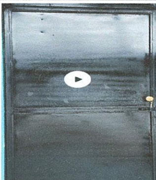
Foto 6: SUSTITUCION DE CHAPAS MARCA YALE
