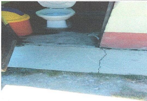
Foto 4: SUSTITUCIÓN DE INODORO
