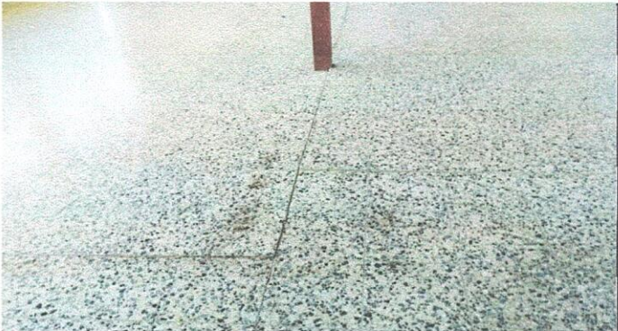
Foto 2.3: SUSTITUCIÓN DE PISO DE GRANITO.
