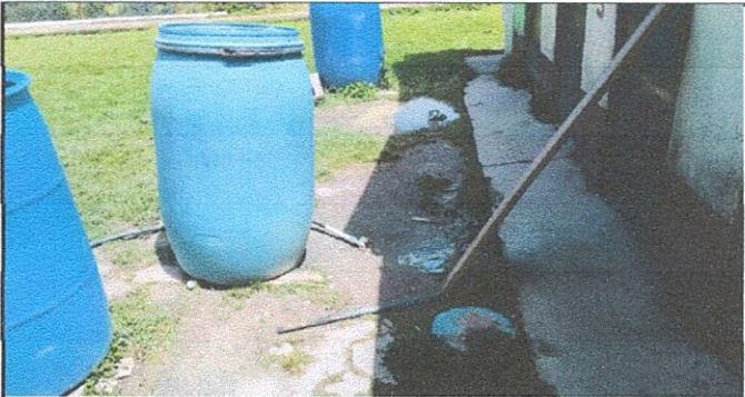
Foto 2.2: SUSTITUCION DE PISO DE TORTA DE CONCRETO, CORREDOR DE BAÑOS.
