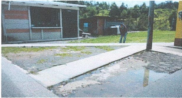
Foto 2.1 : SUSTITUCION O REPARACION DE PISO DE TORTA DE CONCRETO, CORREDOR DE COCINA
