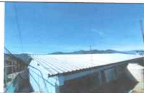
Foto 3: Láminas sustituidas por láminas troqueladas
