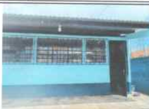
Foto 2: Pintura en interiores y exteriores terminado
