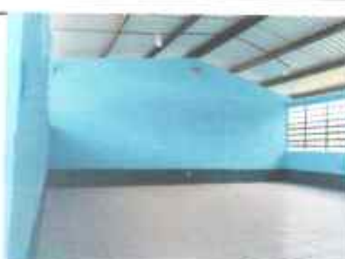
Foto 6: Panorama de piso, pintura, láminas y cableado sustituidos
