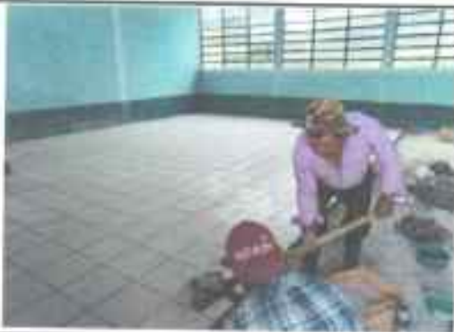
Foto 3: Sustitución de piso en el aula No. 2
