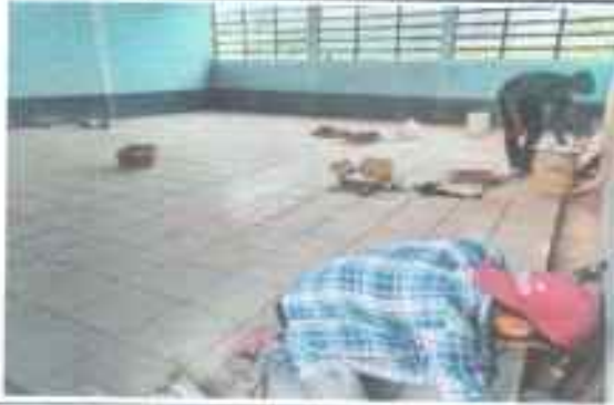
Foto 1: Sustitución de piso en el aula No. 1
