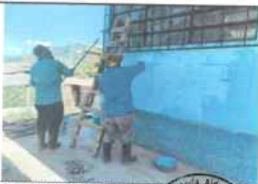
Foto 5: pintura en interiores y exteriores
