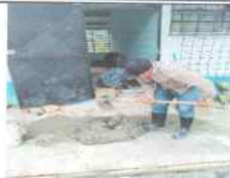
Foto 2: mezcla para la sustitución de piso
