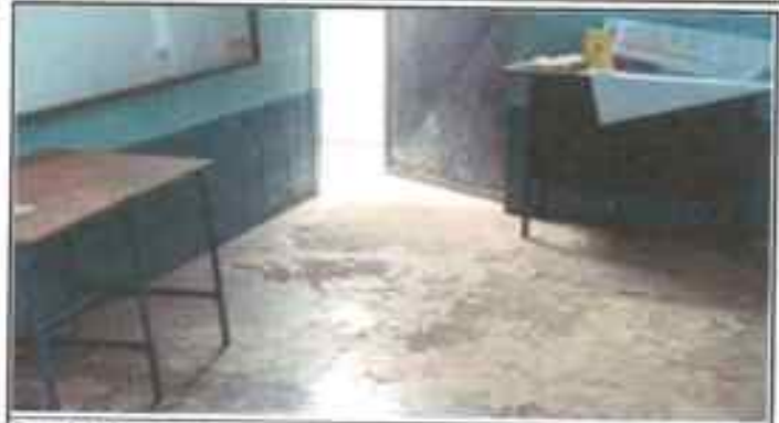
Foto 2.1: Sustitución de piso de cemento a piso de granito.
