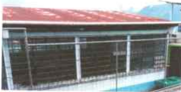
Foto 1: Sustitución de láminas, por láminas troqueladas aluzinc calibre 26
