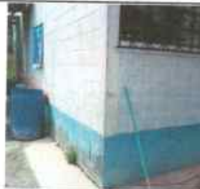
Foto 3.1: Pinturas en muros exteriores e interiores
