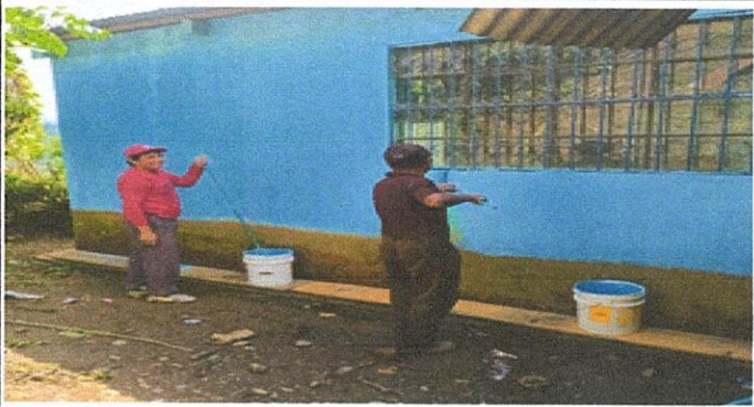
Foto1: Aplicación de pintura en muros exteriores y interiores
