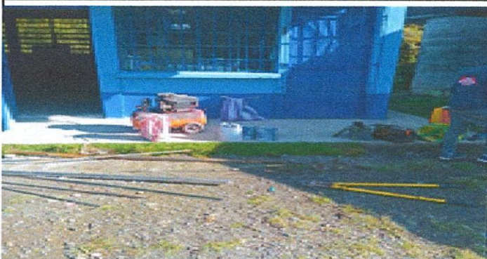
Foto 2: Sustitución de barandas de metal
