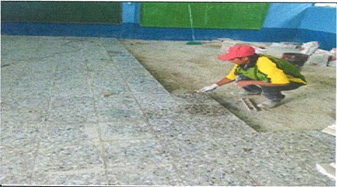
Foto 3: Colocación de piso de granito
