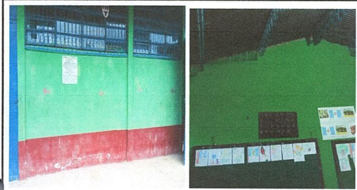
Foto1: Aplicación de pintura en muros exteriores y interiores
