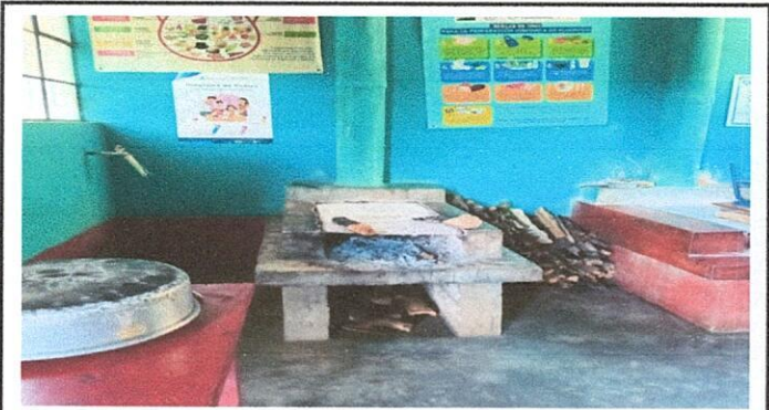
Foto 4: Sustitucion de planca de 3 ornillas
