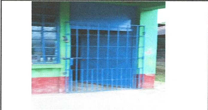
Foto 2: Sustitución de barandas de metal
