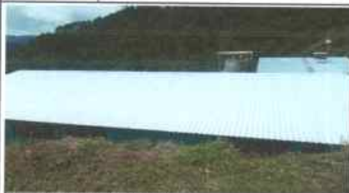
Foto 1: Instalada lamina y costanera
