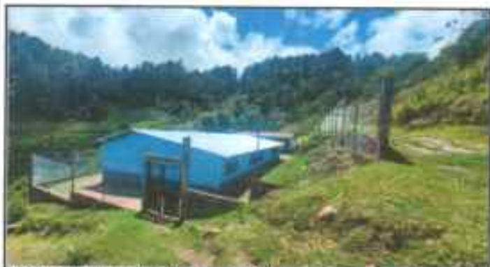
Foto 3: Circulación de Perimetro instalada
