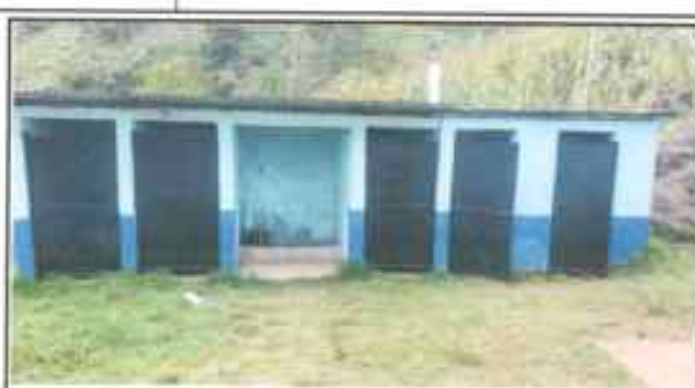
Foto 2: Pintada de baños terminados
