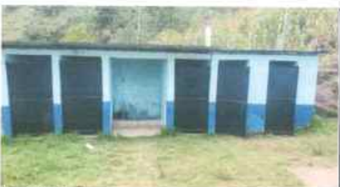
Foto 4: Pintada de puertas terminadas
