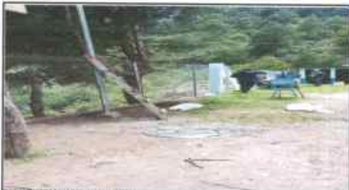
Foto 3: instalación de malla
