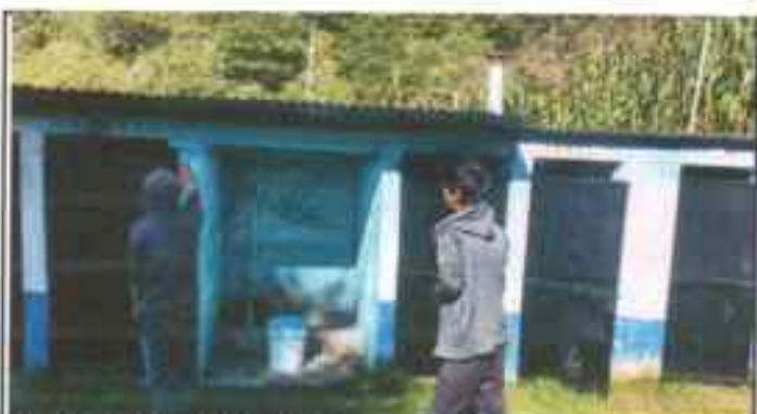
Foto 4: pintando paredes de baños
