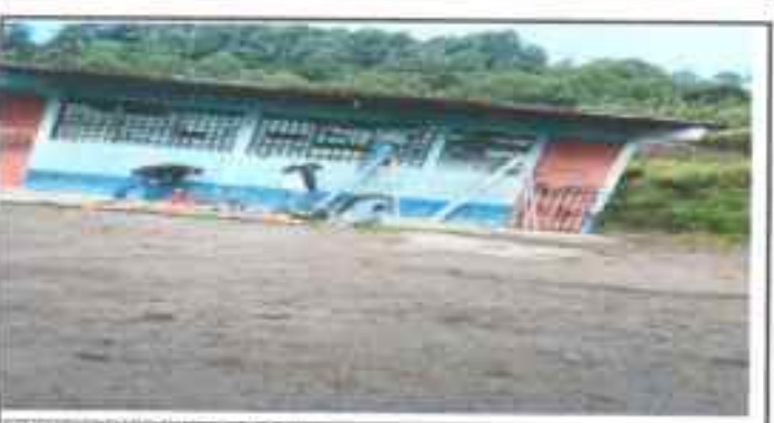
Foto 6: Colocación de Balcones
