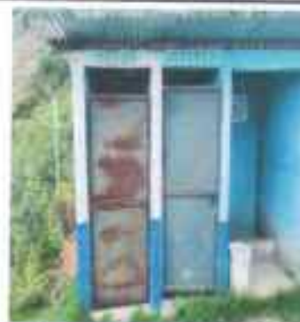
Foto 2: Mantenimiento a estructura a puertas de servicio sanitario
