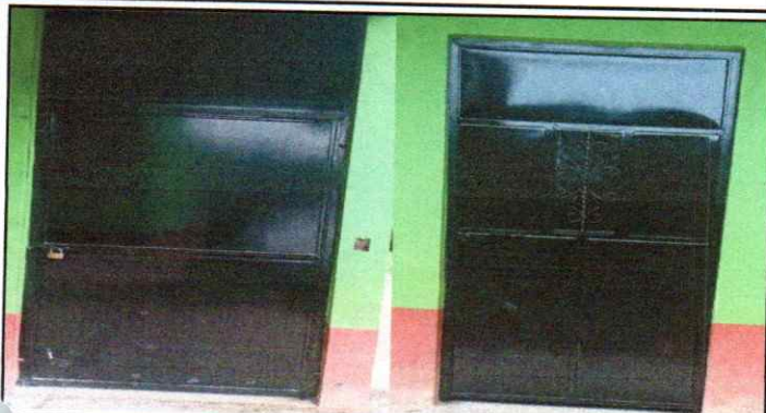
Foto1: Finalizacion de la instalación de puertas
