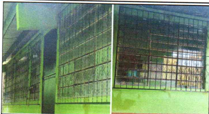
Foto 2: Finalizacion del puesto de balcones
