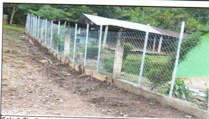
Foto 4: Finalizacion del puesto de tubo hg y colocación de malla galvanizada
