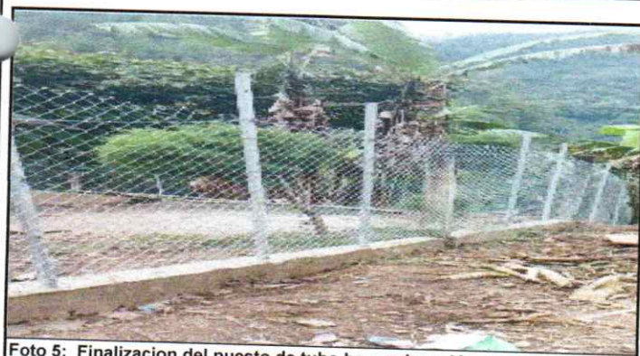
Foto 5: Finalizacion del puesto de tubo hg y colocación de malla galvanizada
