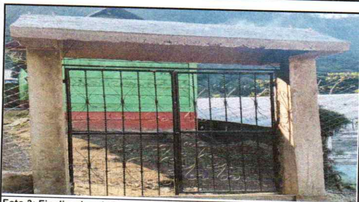
Foto 3: Finalizacion de la instalación de porton
