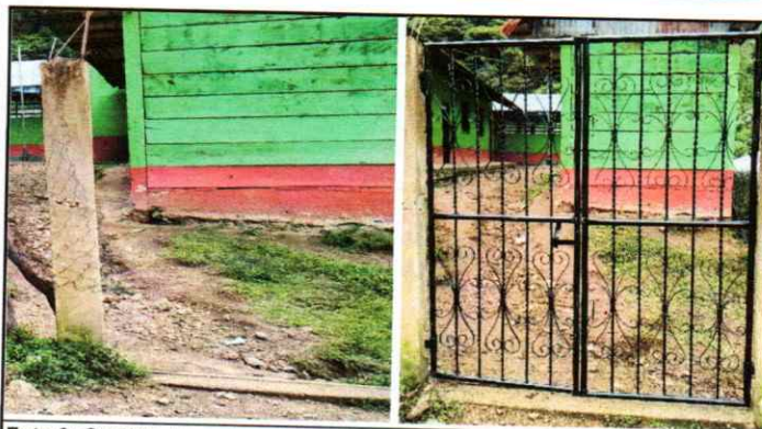
Foto 3: Cambio de porton de metal y madera por metal
