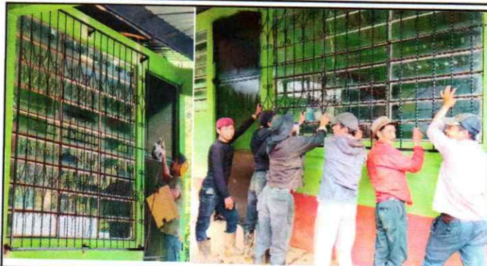
Foto 2: Cambio de balcones
