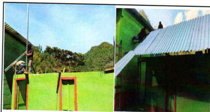
Foto 6: Cambio de lamina , Cambio de capote, Cambio de estructura de soporte de madera por metal
