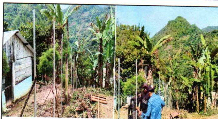
Foto 4: Cambio tubo hg y malla galvanizada
