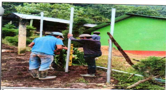
Foto 5: Cambio tubo hg y malla galvanizada
