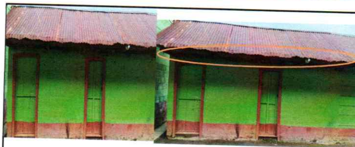
Foto 6: Sustrucción de lamina, sustrucción de capote, sustrucción de estructura de soporte de madera
