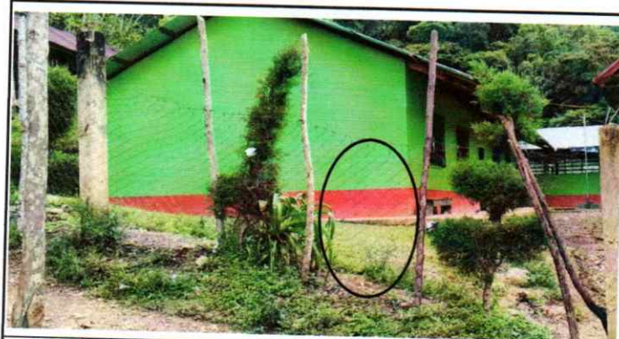
Foto 4: Sustrucción de tubo hg y malla galvanizada
