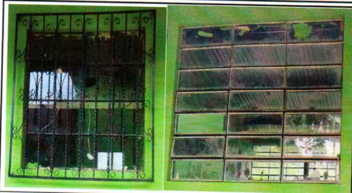
Foto 2: Sustrucción de balcones
