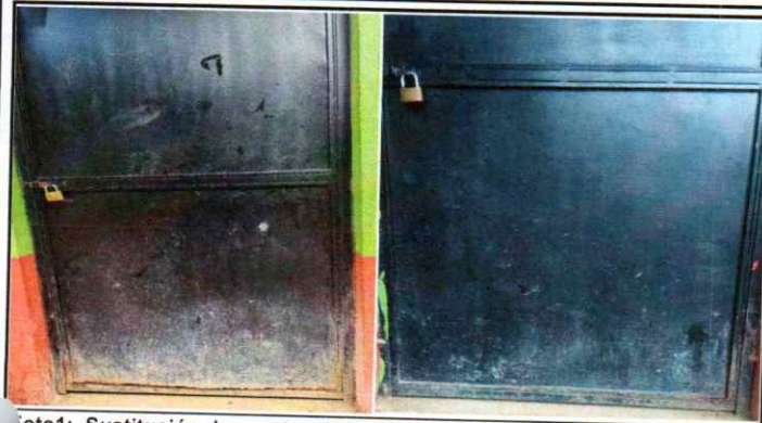
Foto 1: Sustrucción de puertas de metal
