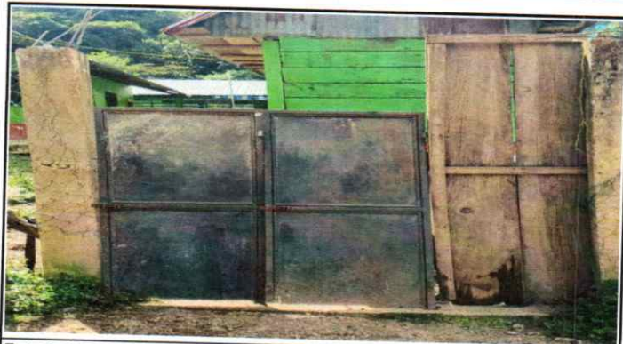
Foto 3: Sustrucción de porton de metal y madera
