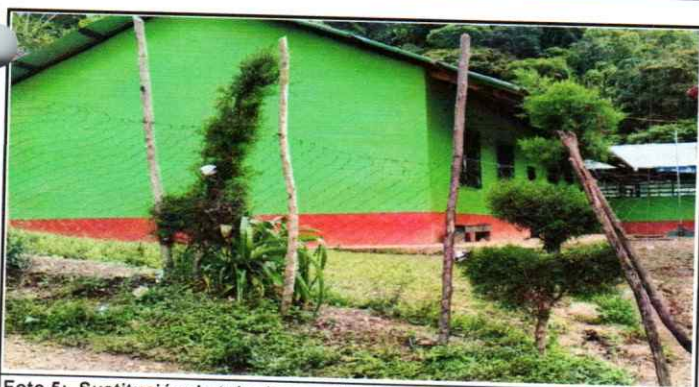
Foto 5: Sustrucción de tubo hg y malla galvanizada
