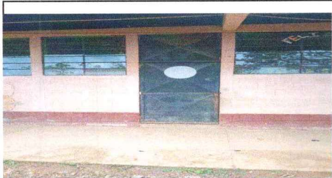
Foto 7: Mantenimiento a estructura (jijado y aplicación de pinturas)
