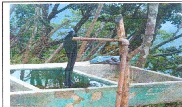
Foto 9: Sustitucion de chorro
