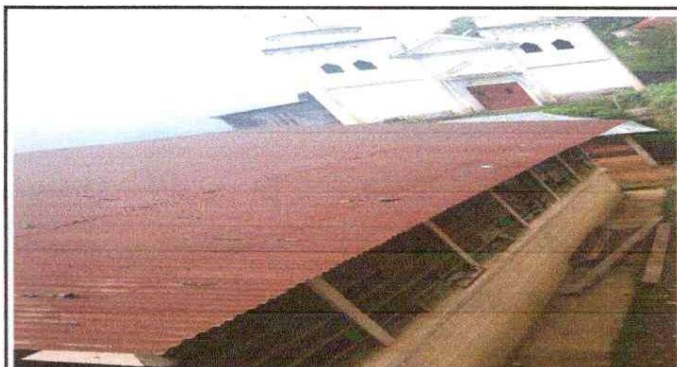
Foto 4: Mejoramiento de canales y bajadas de agua pluvial
